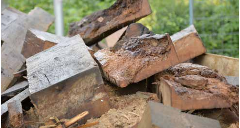
Vom „Gemeinen Nagekäfer“ befallener Balken aus dem Turm der Wilhelmskirche
