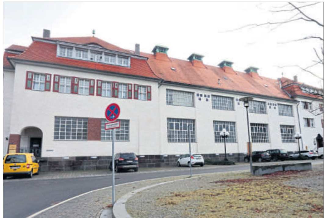
Die Familienbildungsstätte gibt ihr bisheriges Domizil in der Bad Nauheimer Alten Wäscherei aus Kostengründen auf. Die Stadt würde gerne als Nachmieter einsteigen.
