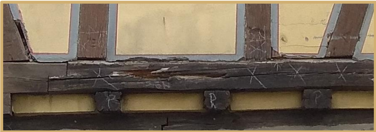
Ein Teil der im Vorfeld sichtbaren Schäden, die beseitigt wurden. Fotos Silke Nickel
