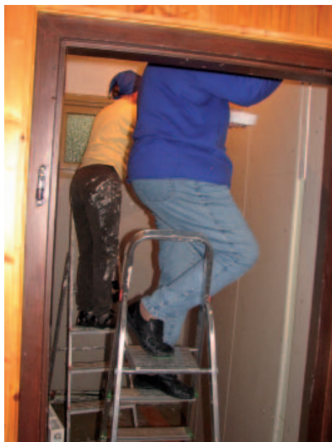
Frauenpower pur: Lisa Diedrich (hinten) und Hannelore Haydl waren für Spachtel- und Farbarbeiten zuständig
